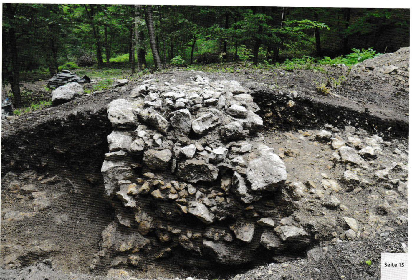
Abb. 3: Burganlage Hengst. Quadratischer Turm (9 x 9 m) aus Kalkbruchsteinen in Schalenmauertechnik. (Foto: KP Hengist/Maria Mandl).
